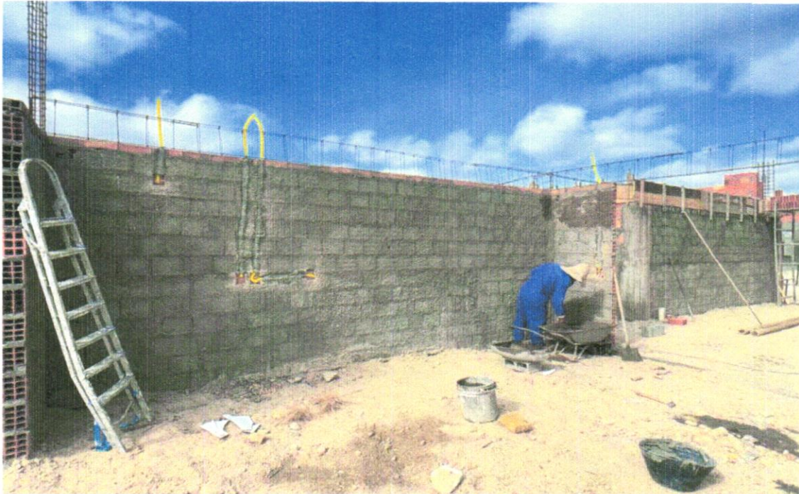
FOTO 30 – Emboço para paredes internas traço 1:2:9 - preparo manual - espessura 2,0 cm
