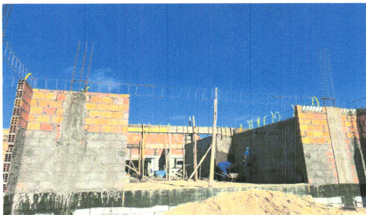
FOTO 10 – Armação de aço CA-50 Ø 8mm; incluso fornecimento, corte, dobra e colocação
