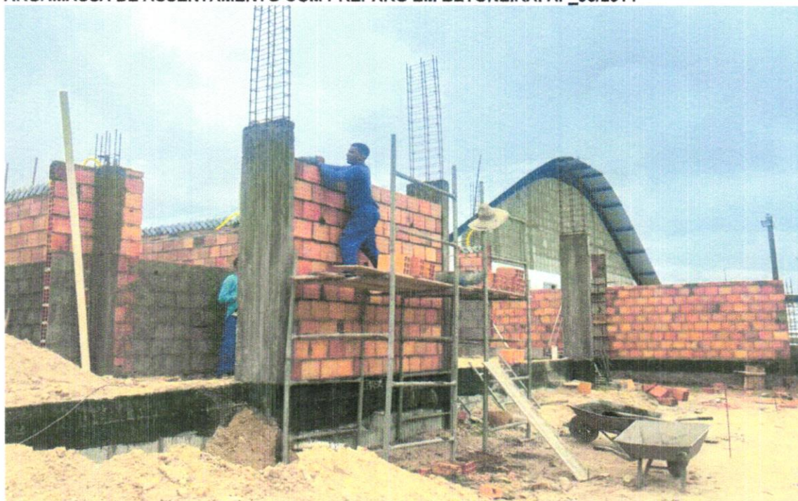
FOTO 20 – ALVENARIA DE VEDAÇÃO DE BLOCOS CERÂMICOS FURADOS NA HORIZONTAL DE 9X19X19CM (ESPESSURA 9CM) DE PAREDES COM ÁREA LÍQUIDA MAIOR OU IGUAL A 6M² COM VÃOS E ARGAMASSA DE ASSENTAMENTO COM PREPARO EM BETONEIRA. AF_06/2014
