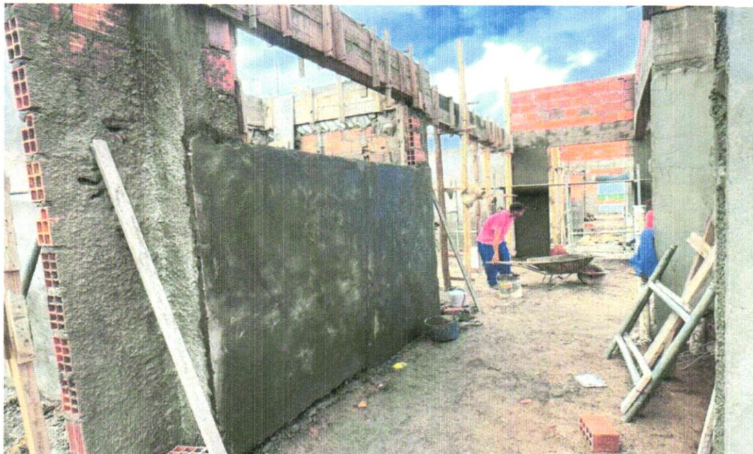
FOTO 18 - Verga e contra verga pré-moldada fck= 20MPa, seção 10x10cm
