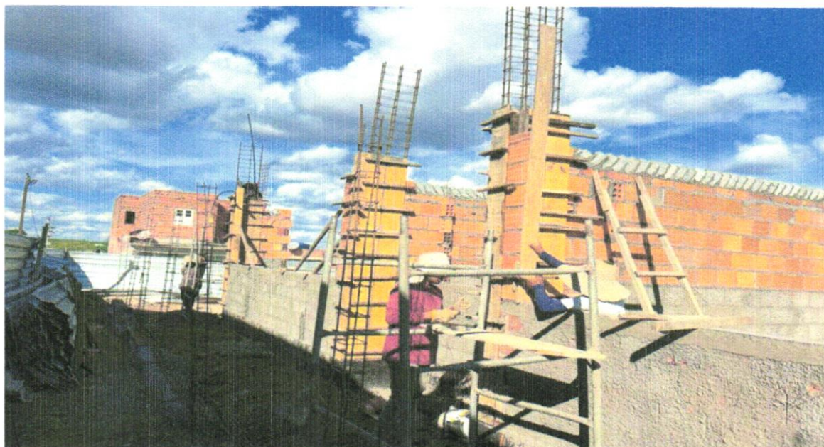
FOTO 02 - Concreto Bombeado fck= 25MPa; incluindo preparo, lançamento e adensamento
