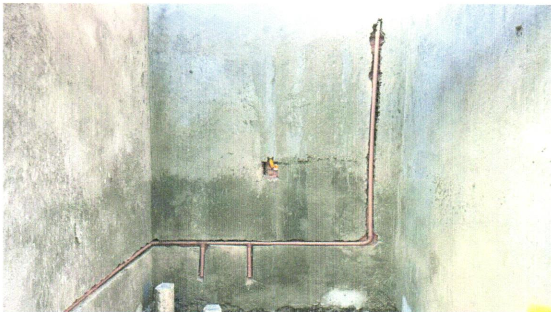
FOTO 41 – Tê redução 90° soldável com bucha latão B central - 25mm - 1/2"
